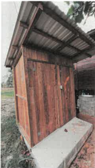
Baños exteriores uso Palapa
