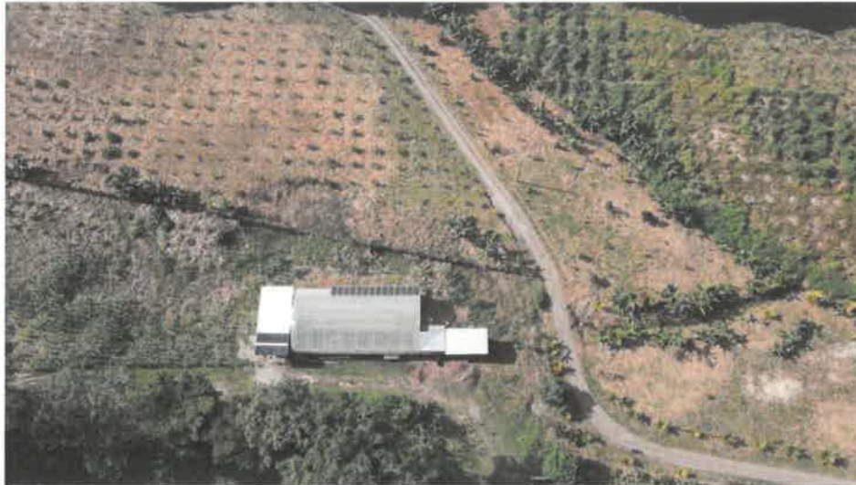
Placas solares totales (FASE I y FASE II)
